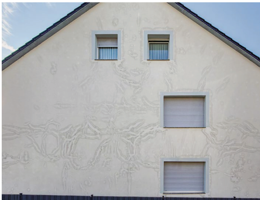
2 | WDVS mit richtungslosen Haarrissen
