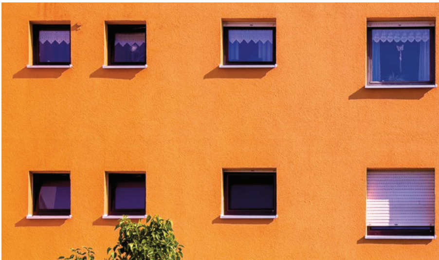
7 | Beispielobjekt Wohnhaus: Fassade nach Instandsetzung (10 Jahre), Foto vom 12.07.2026
